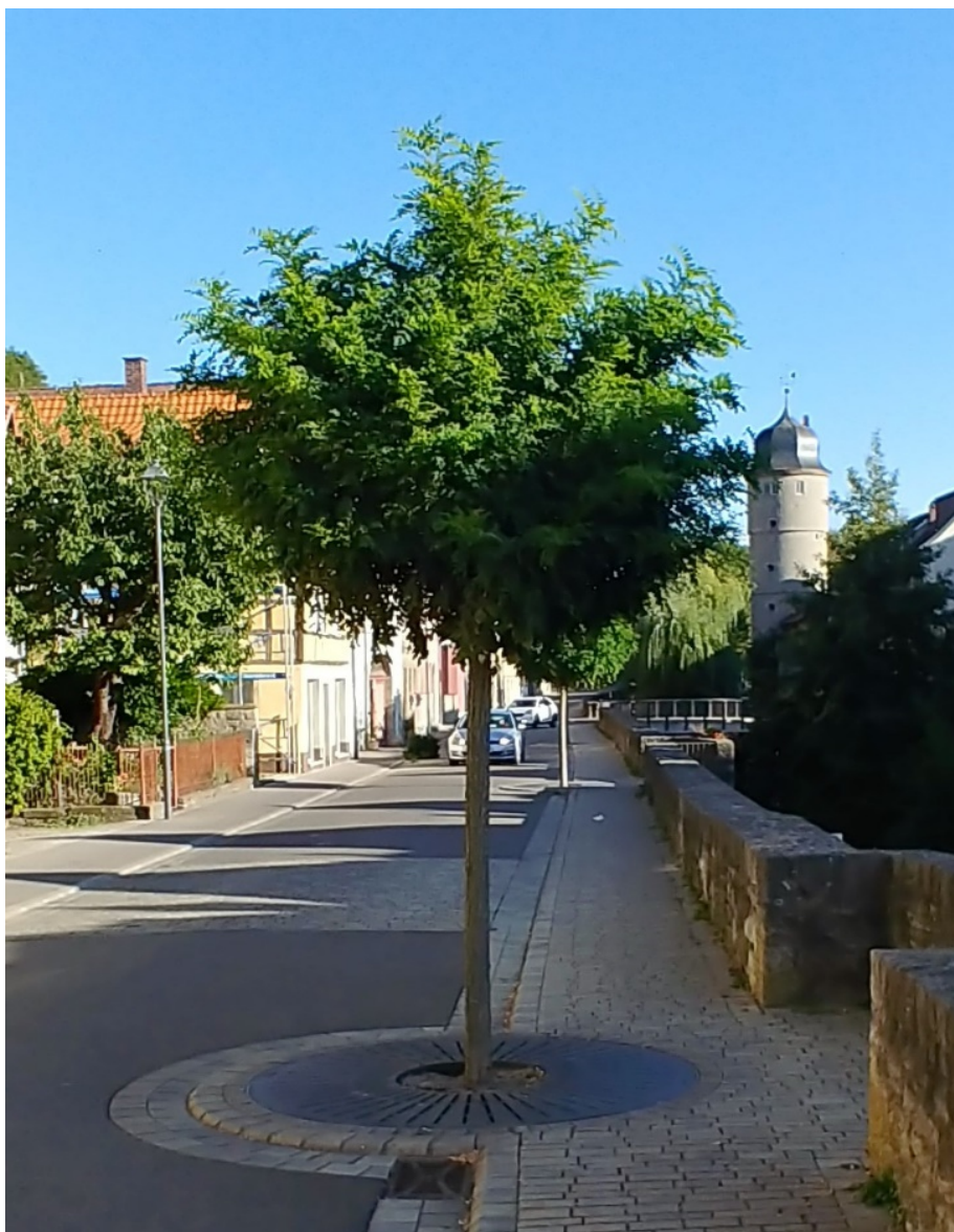
Marktbreit (Unterfranken): eine schöne Lösung, selbst für stärker befahrene Straßen: eine überfahrbare, geschmiedete Baumscheibe
